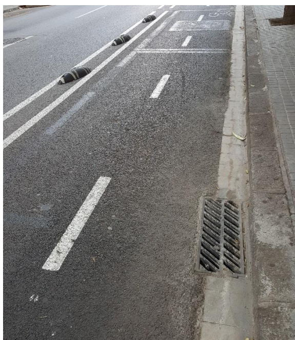
Figura 171 - Modelo de grelha usada em ciclofaixas em Barcelona (Fonte: Autoria própria)
