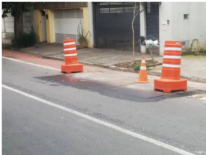
Figura 146 - Obra de saneamento na ciclofaixa (Fonte: Autoria própria)
