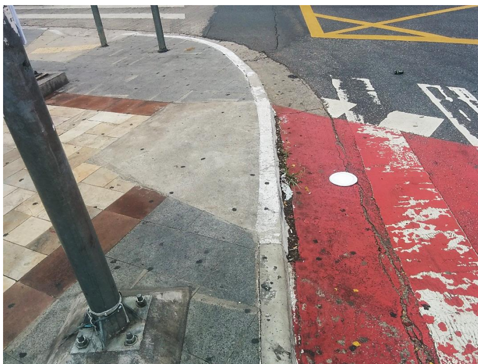
Figura 155 - Guia alta no acesso à ciclovia (Fonte: Autoria própria)
