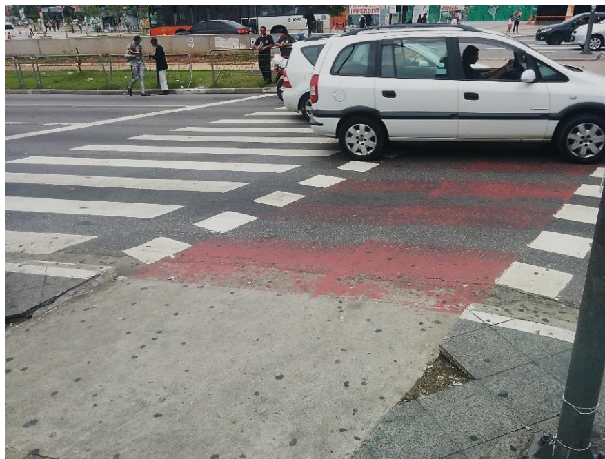
Figura 156 - Rebaixamento de calçada fora de especificação (Fonte: Autoria própria)
