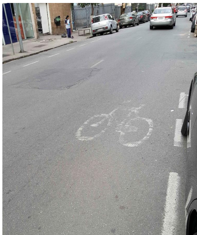
Figura 119 - Sinalização horizontal muito desgastada pelo tráfego (Fonte: Autoria própria)
